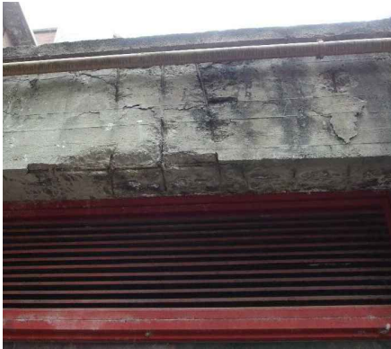
Individuazione locali ammaloramenti Trave - Blocco 3
