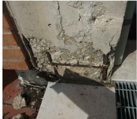
Individuazione locali ammaloramenti Pilastro n. 53 - Blocco 5
