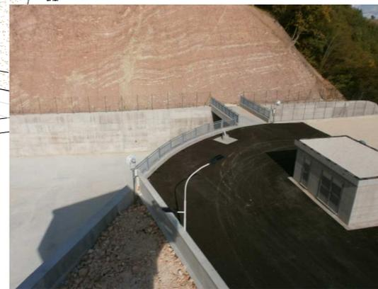
Particolare scarico di superficie con relativa passerella carrabile e vista del locale tecnico
