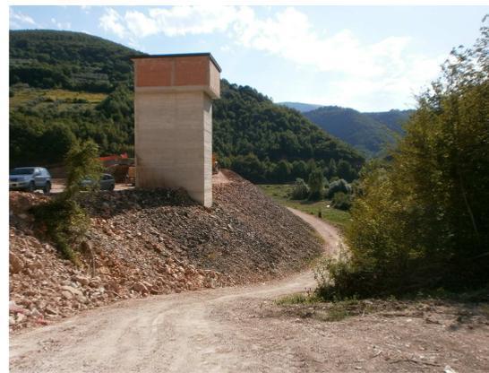
3 - ABBASSAMENTO CORONAMENTO CORPO DIGA E VISTA CABINA DI MANOVRA PARATOIE
