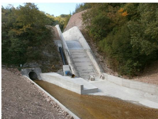
16 - CANALE DI SCARICO SUPERFICIALE, CANALE DI SCARICO DI FONDO E TUBAZIONE PREDISPOSIZIONE IMPIANTO IDROELETTRICO
