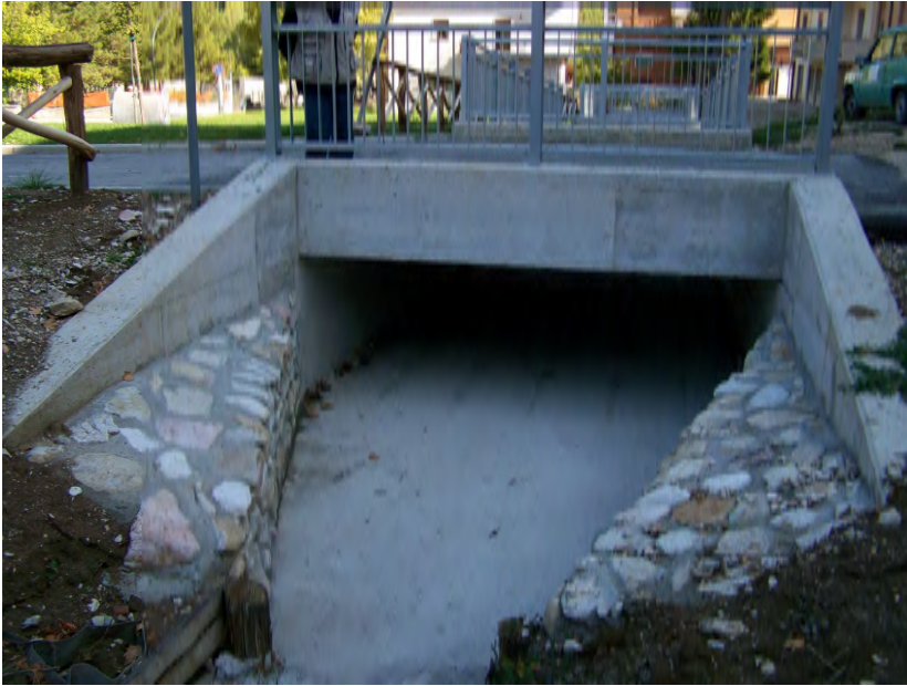
Particolare raccordo con ponte di nuova realizzazione
