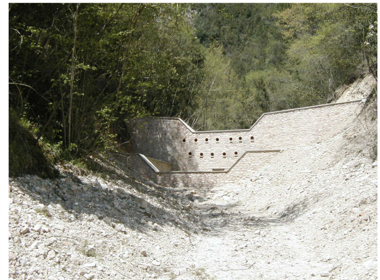
8 - BRIGLIA N.2: VISTA LATO VALLE A LAVORI ULTIMATI
