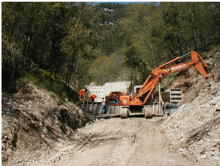
5 - BRIGLIA N.2: VISTA LATO VALLE DURANTE I LAVORI
