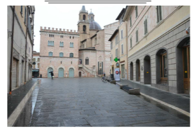
FOTO DURANTE I LAVORI
