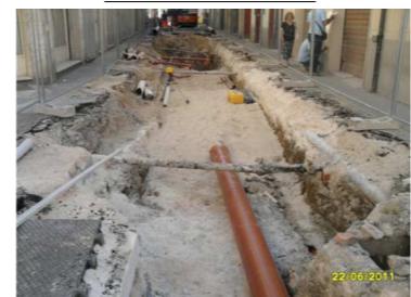
FOTO DURANTE I LAVORI
