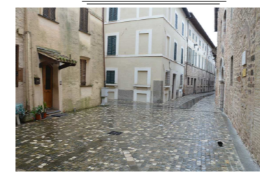
FOTO DURANTE I LAVORI
