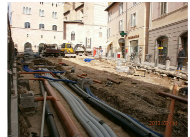
FOTO DURANTE I LAVORI
