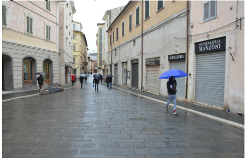
Fig. 6 - Largo Carducci (a lavori finiti)
