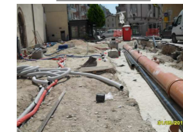
FOTO DURANTE I LAVORI
