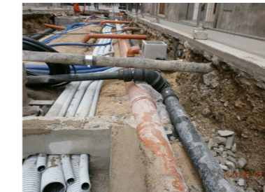
FOTO DURANTE I LAVORI
