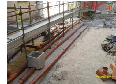
FOTO DURANTE I LAVORI
