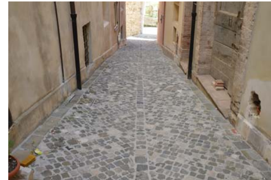
Pavimentazione in acciottolato
