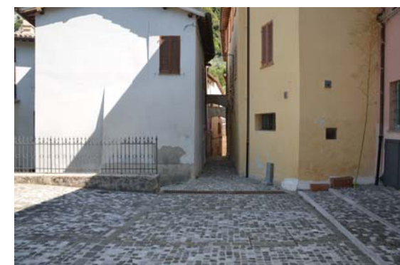
Pavimentazione in acciottolato
