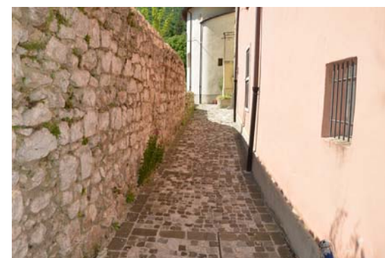
Pavimentazione in acciottolato
