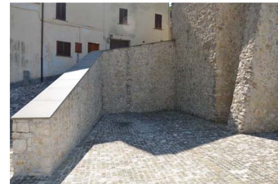
Pavimentazione in acciottolato
