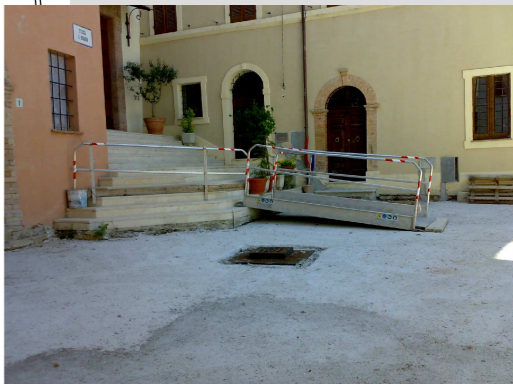
Opera provvisoria per garantire la transibilità pedonale
