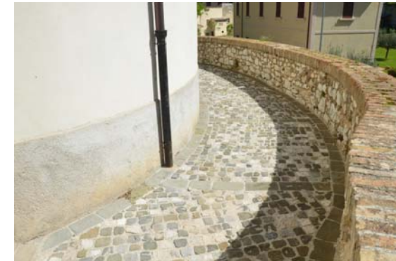
Pavimentazione in acciottolato
